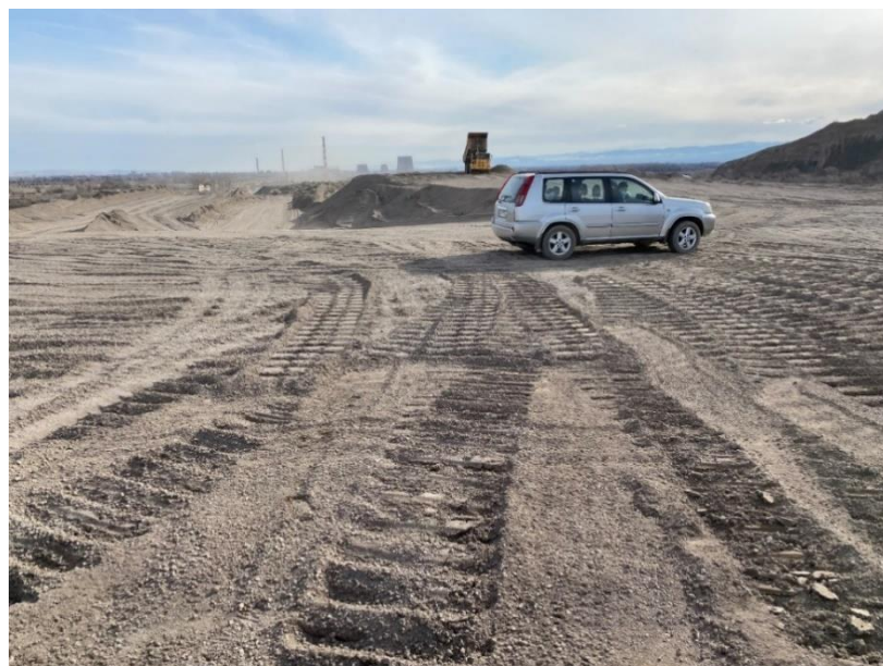
სურ. 16. სანაყაროს თავზე მოსწორებული მოედანი გადამუშავებული ნარჩენების ახალი პორციის დასასაწყობებლად
